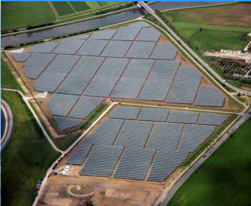
Central fotovoltaica Serpa
