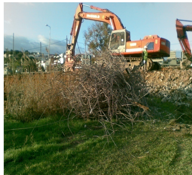
Remoção de ferro separado em obra
