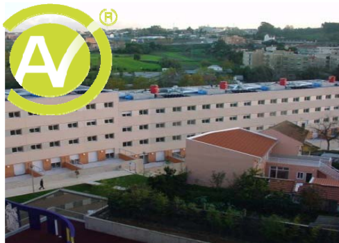
Ponte da Pedra Fase II (Matosinhos)
