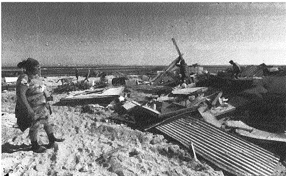
Programa Polis Litoral realizou, ontem, a demolição das construções no ilhote das Ratas
