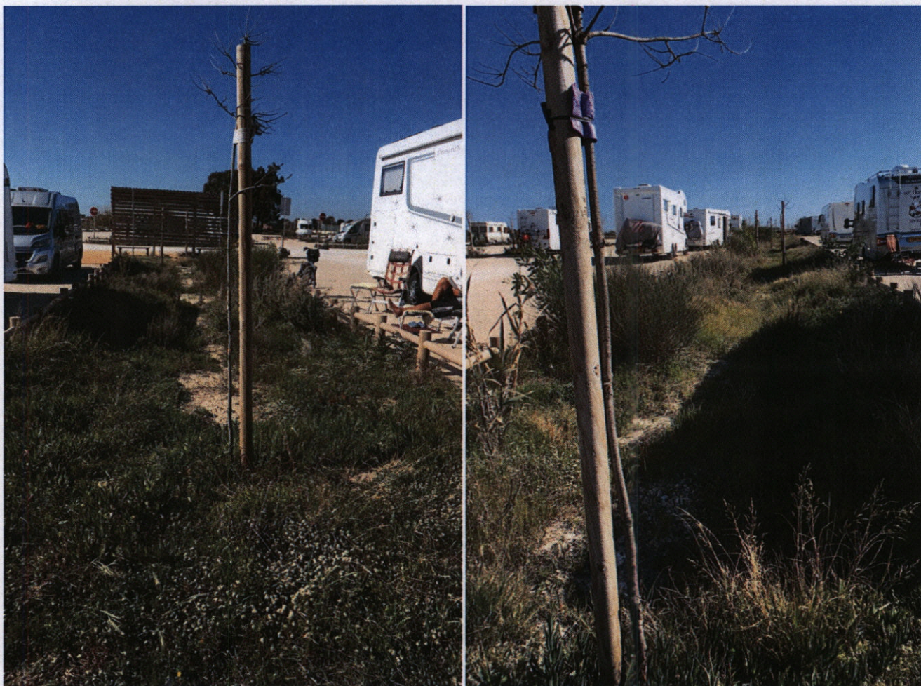
Fotografia 4 – Bacia de Infiltração
