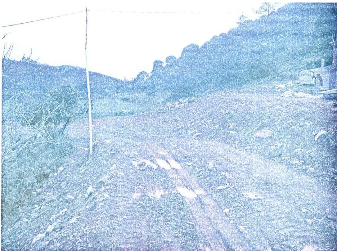
Foto 5 – Vista da zona em frente da construção, com acertos na modelação de terras e remoção do aterro com terras anteriormente existente no 'leito de cheia'.
