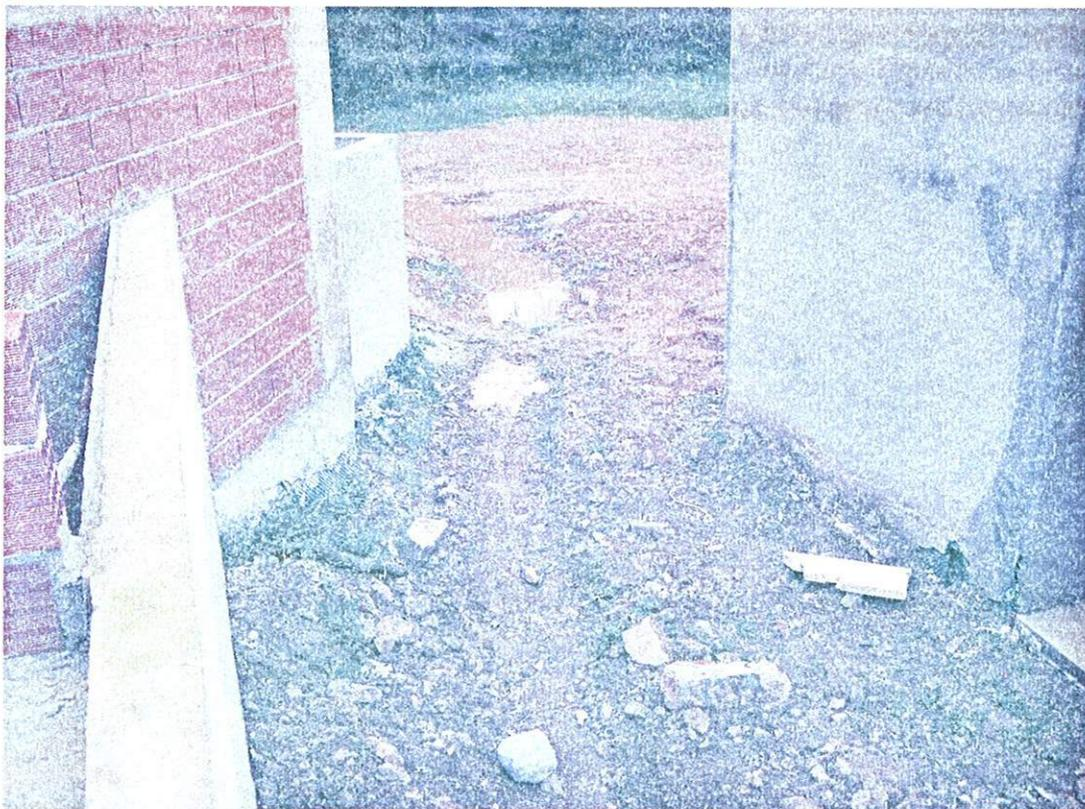
Foto 13 – Pormenor do espaço existente entre os dois corpos da construção em causa, para não obstruir o escoamento de uma pequena linha de água que se situa entre ambos, afluente da ribeira do Monte Novo.
