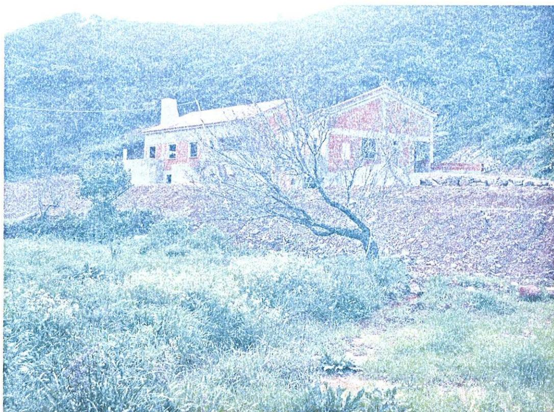
Foto 2 – Vista geral da construção para turismo rural, à direita, o ‘Corpo Norte’, e à esquerda, o ‘Corpo Sul’, implantada no sopé da encosta e numa cota elevada em relação ao ‘leito de cheia’ (primeiro plano).
