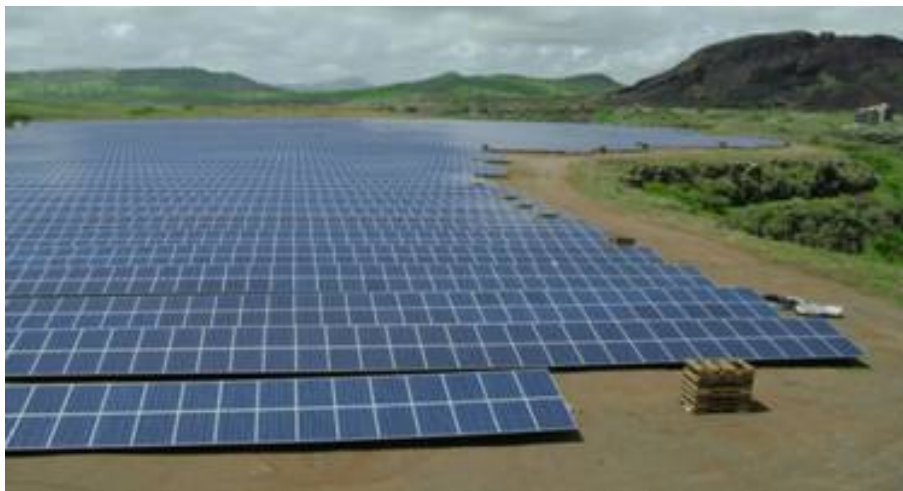
Figura 5.1 – Exemplo de Central Fotovoltaica
