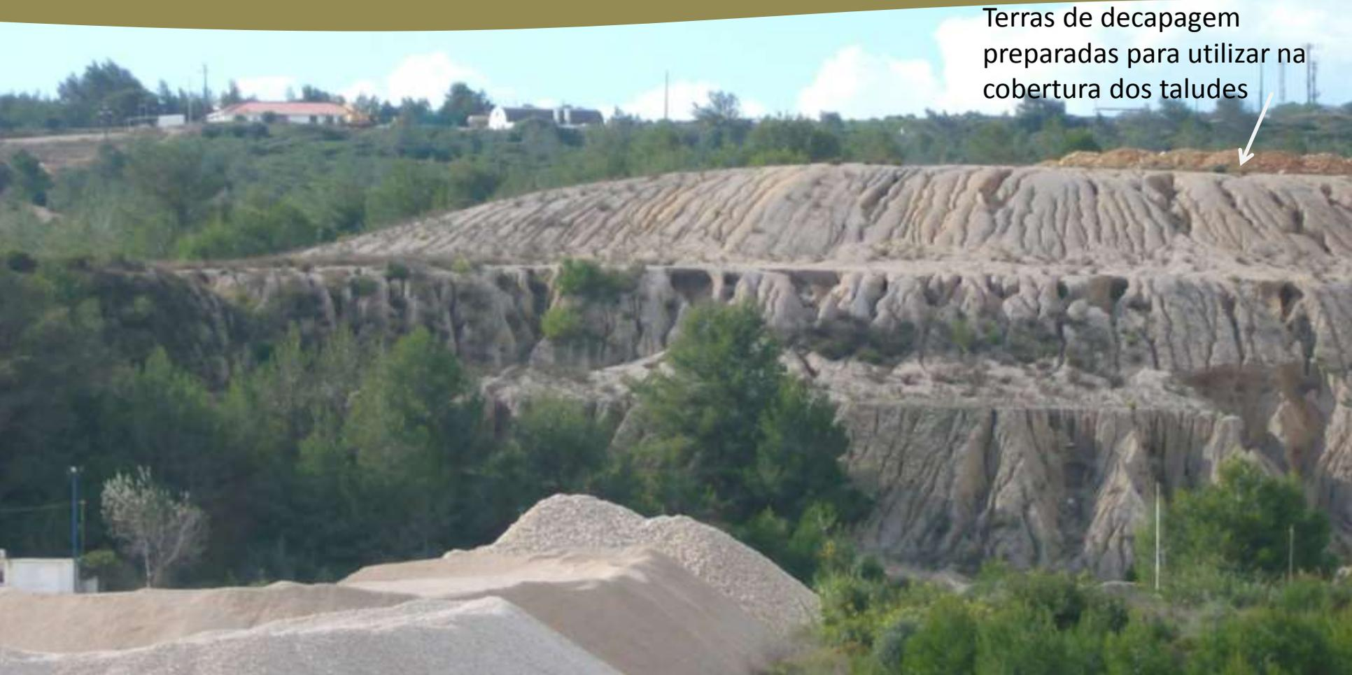
Terras de decapagem preparadas para utilizar na cobertura dos taludes
