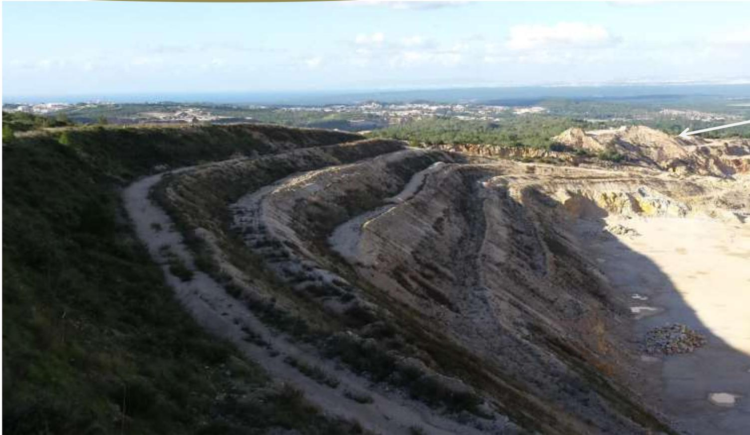
Rejeitados utilizados na modelação topográfica da pedreira adjacente
