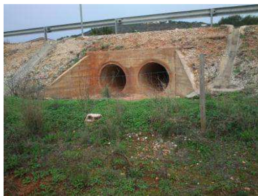
Figura 36 - Boca em aterro, a jusante, da passagem hidráulica existente PHE-4
