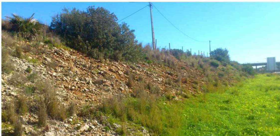
Figura 21 - Aspecto de talude da A22 com afloramento dos calcários de Sta. Bárbara de Nexe
