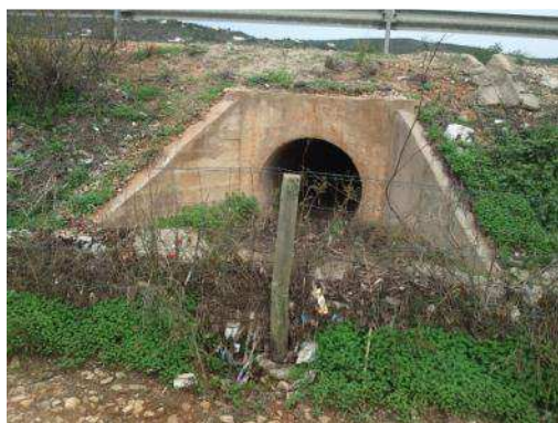
Figura 37 - Boca em aterro, a jusante, da passagem hidráulica existente PHE-5
