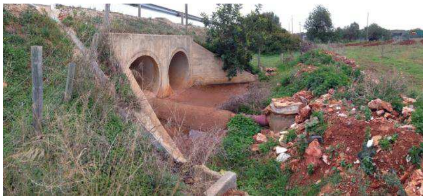
Figura 34 - Boca em aterro e área adjacente, a jusante, da passagem hidráulica existente PHE-3
