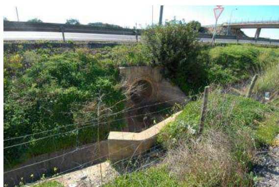
Figura 38 - Boca em aterro, a montante, da passagem hidráulica existente PHE-6
