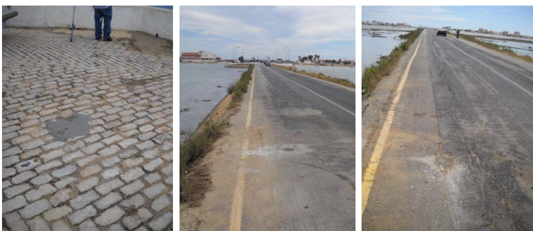
Figura 6.4 – Colmatação da boca dos furos S3 (esq.), S4 (centro) e S5 (dir.)
