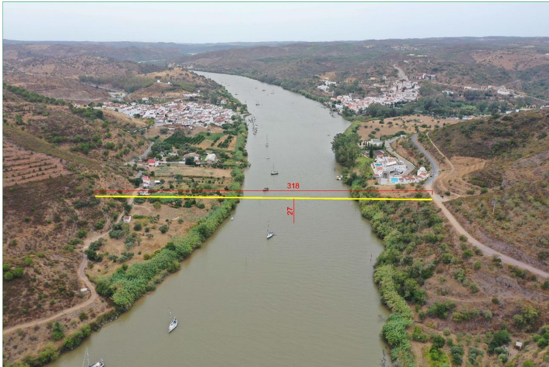
Fotografia 02 – Localização sobre imagem obtida por drone Ubicación en imagen obtenida por dron
