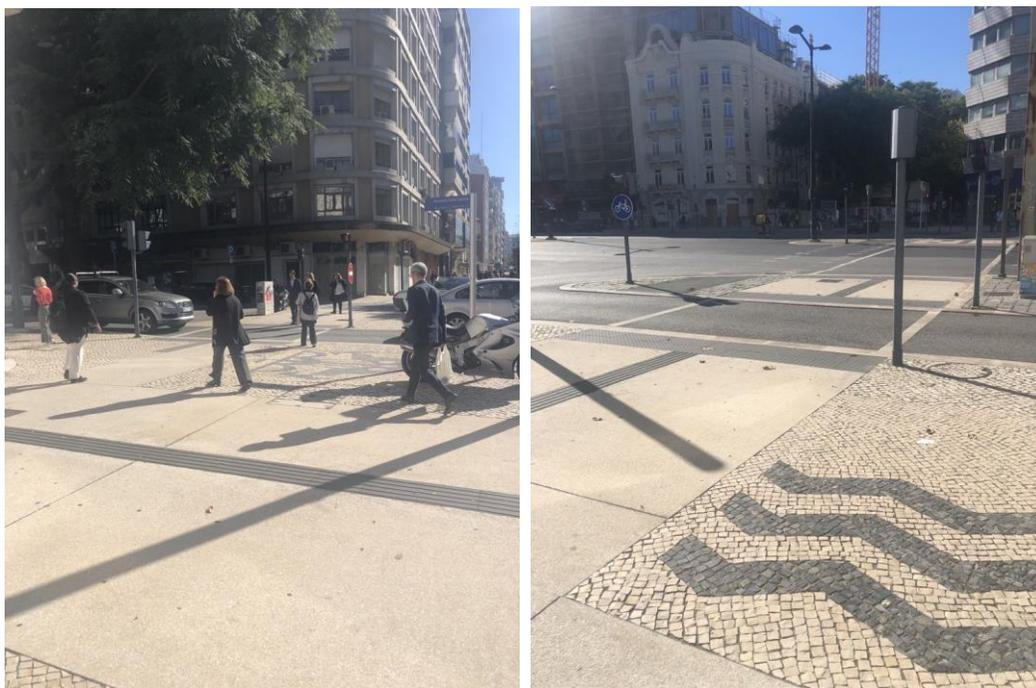
Utilização de pavimento confortável / liso para melhorar o conforto e a segurança da caminhada e o pavimento tátil para auxiliar o trajeto de pessoas com a visão reduzida (Lisboa).
