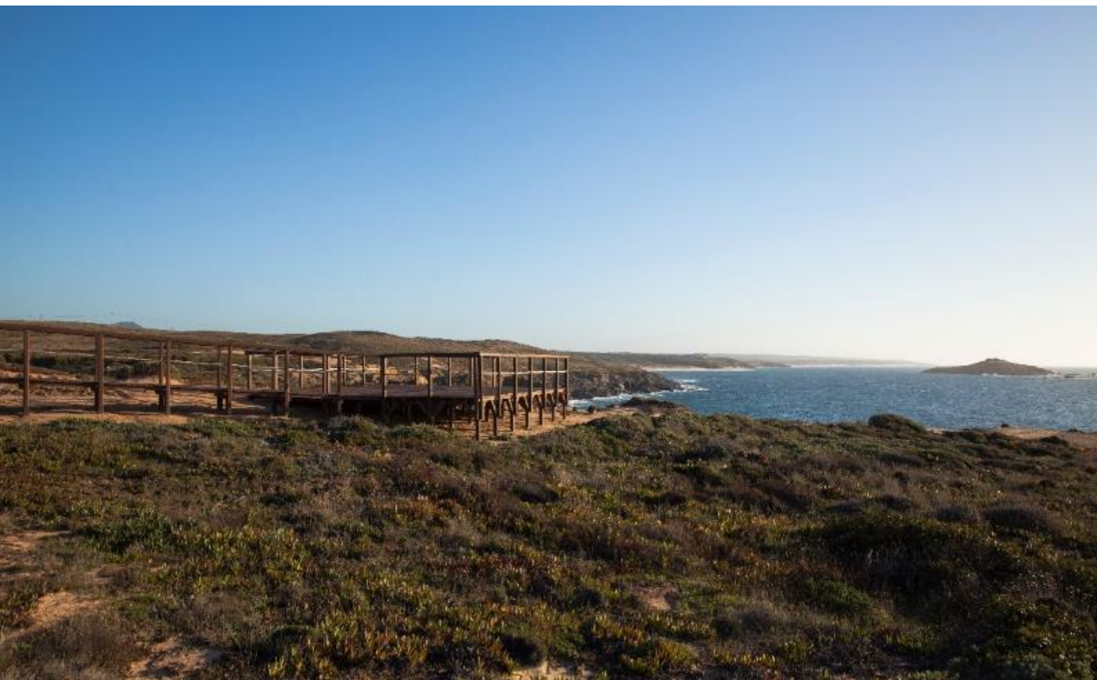
Figura 7 - Passadiços e miradouros entre Porto Covo e a Ilha do Pessegueiro (Fonte: Polis Litoral Sudoeste)
