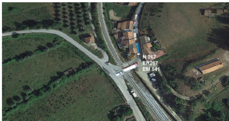
Imagem 1- Passagem de nível de São Marcos da Serra – circulação de veículos pesados
