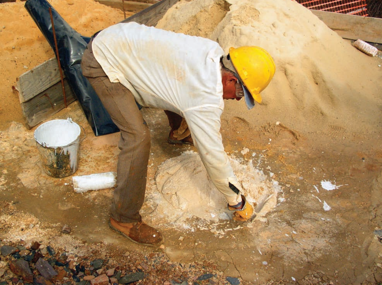
Amassadura da areia com a cal. Obra de Reconstrução do Moinho Branco (projecto e acompanhamento de obra: GTAA Sotavento). Cachopo, Tavira. fotografia GTAA Sotavento
