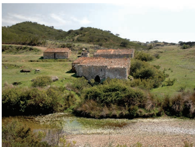
Conjunto constituído por dois moinhos de duas moendas, habitação, ramada e forno de pão. Moinho dos Furadoiros, Alcoutim. fotografia Hélder Oliveira
