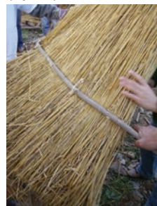
da esquerda para a direita e de cima para baixo Oficina “Materiais e técnicas de construção tradicional: conhecer para agir” (organização: GTAA Sotavento, Novembro 2007). Cachopo, Tavira. Exercício de amarração no sistema de ripagem dupla.
