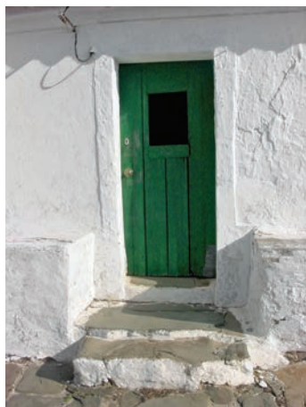
em baixo, da esquerda para a direita Vão de porta com as golas executadas em tijoleira de barro cozido. Cachopo, Tavira; Vão de porta de habitação com ombreiras e respectivas golas em pedra, verga constituída por paus de azinheira e soleira em laje de pedra. Vaqueiros, Alcoutim; Vão de porta com moldura, rebocado e caiado. Rocha dos Corvos, Tavira.
