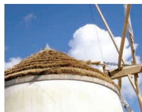
Vista interior da estrutura radial e roda de ponto (em cima) da cobertura cônica de moinho de vento; Cobertura cônica de moinho de vento, revestida com palha de centeio, integrando a abertura para o mastro. Obra de Reconstrução do Moinho Branco (projecto e acompanhamento de obra: GTAA Solavento). Cachopo, Tavira.
