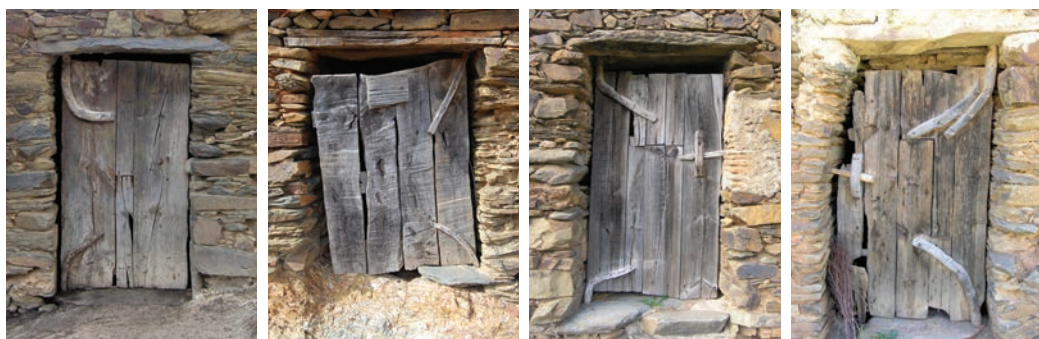
da esquerda para a direita Portas (tipo E) de ramada, de taipal de madeira, de folha única, com gonzos e fechos de madeira. (1) Grainho, Tavira; (2-4) Madeiras, Alcoutim.
