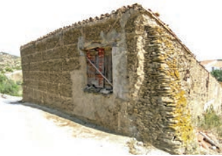
Ramada construída em taipa. Cortes Pereira, Alcoutim.
