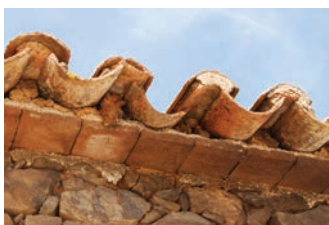
de cima para baixo Telha de canudo, Julião, Tavira; Barrocal, Julião, Tavira; Telha de canudo e tijoleira, na conformação de beirado. Estevais, Tavira.
