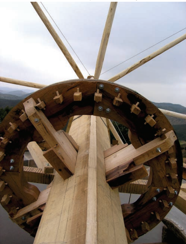
Moinho Branco de Cachopo, Tavira. Mastro, entrosga e varas; Colocação do carrete e do veio de cima.
