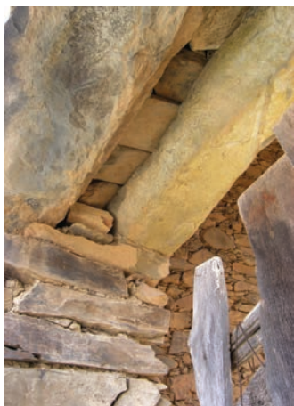
de cima para baixo Pormenor construtivo de um cunhal e seu travamento. Madeiras, Alcoutim.
