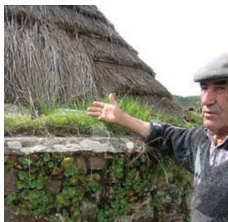
Cobertura cônica de palheiro de planta circular revestida com palha de centeio. Mealha, Tavira.
