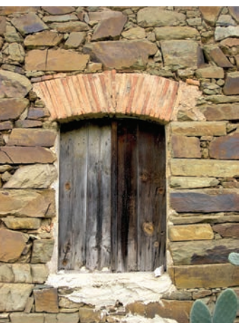
Vão de porta de ramada com ombreiras de pedra, sem golas, e verga constituída por grandes pedras de xisto. Velhas, Alcoutim; Vão de janela de habitação com ombreiras em pedra e verga em arco abalado executado com tijolos de barro cozido. Vaqueiros, Alcoutim; Vão de janela. Fortes, Castro Marim. fotografia GTAA Solavento [1, 3, 4], Miguel Reimão Costa [6]
