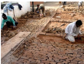
de cima para baixo Calçada irregular de xisto. Obra de Requalificação do acesso ao poço (projecto e acompanhamento de obra: GTAA Sotavento). Cachopo, Tavira. fotografia Vitor Ribeiro (1)
