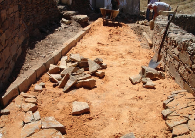
da esquerda para a direita Desenvolvimento da execução de um lancil, numa calçada irregular de xisto. Obra de Requalificação da azinhaga de acesso às construções de planta circular (projecto e acompanhamento de obra: GTAA Sotavento). Cachopo, Tavira. fotografia Sílvia Bento
