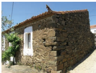
de cima para baixo Muro de divisão de propriedade em alvenaria de pedra seca. Tacões, Alcoutim; Cunhal em muro de alvenaria de xisto. Silgado, Alcoutim, fotografia Marta Almeida; Muro de divisão de propriedade em alvenaria de pedra assente com argamassa de barro. (obra da Requalificação do acesso ao poço. Projecto e acompanhamento de obra: GTAA Sotavento). Cachopo, Tavira. Muro de divisão de propriedade, junto a ribeira, com o assentamento das pedras executado ao alto. Mealha, Tavira; Ramada. Mestras, Alcoutim; Habitação construída em alvenaria de xisto à vista. Tacões, Alcoutim.
