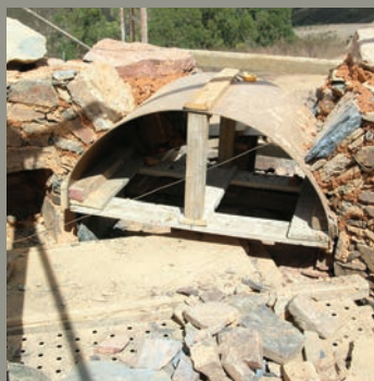
(5-8) Processo de execução de um vão de janela em falsa abóbada. Obra de Reconstrução do Moinho Branco (projecto e acompanhamento de obra: GTAA Sotavento). Cachopo, Tavira. fotografia Alexandre Costa
