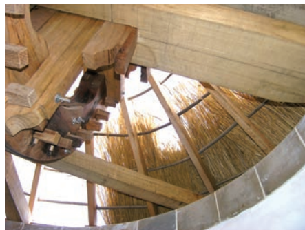
Aspectos da execução de cobertura cónica de palha de centeio. Moinho Branco de Cachopo, Távora.
