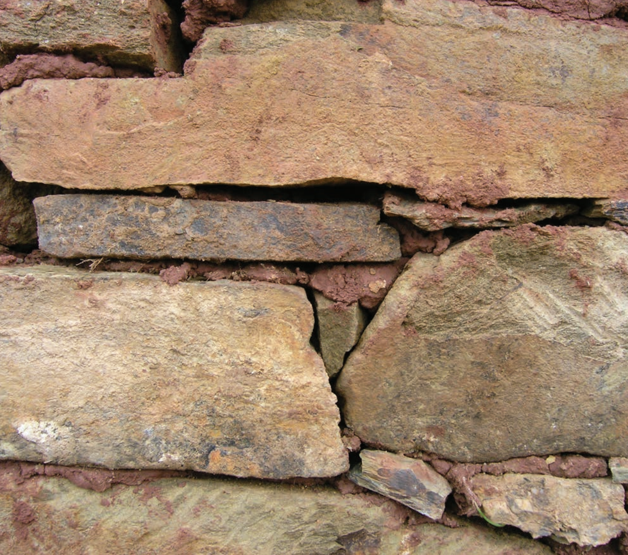
Alvenaria de xisto argamassada com barro. Obra da Casa da Aldeia e Jardim de Cachopo (projecto e acompanhamento de obra: GTAA Sotavento). Cachopo, Tavira.
