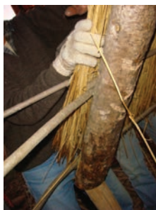
da esquerda para a direita e de cima para baixo Oficina “Materiais e técnicas de construção tradicional: conhecer para agir” (organização: GTAA Sotavento, Novembro 2007). Cachopo, Tavira. Exercício de amarração no sistema de ripagem dupla.
