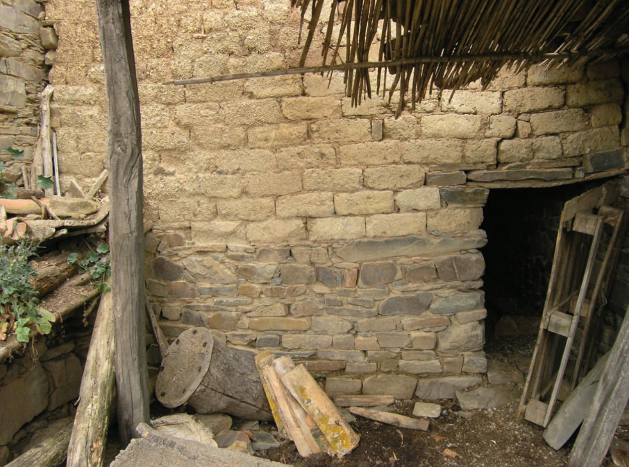
Parede de alvenaria de adobes construída sobre embasamento em alvenaria de xisto. Monte da Estrada, Alcoutim.
