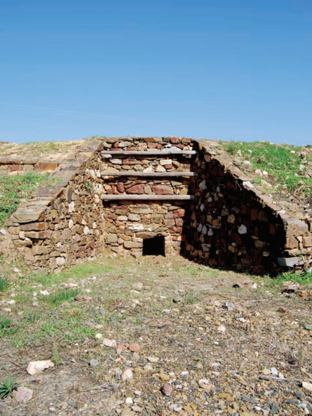
Entrada do forno de cal. Santa Rita, Vila Real de Santo António.
