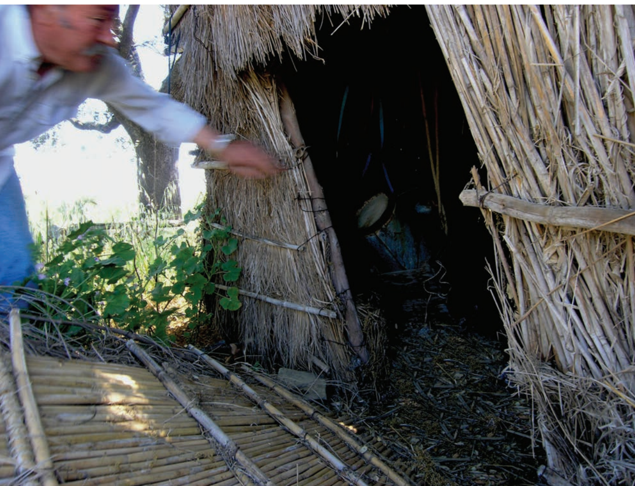
Vão de acesso à cabana, encerrado por cancela. Torneiro, Alcoutim.
