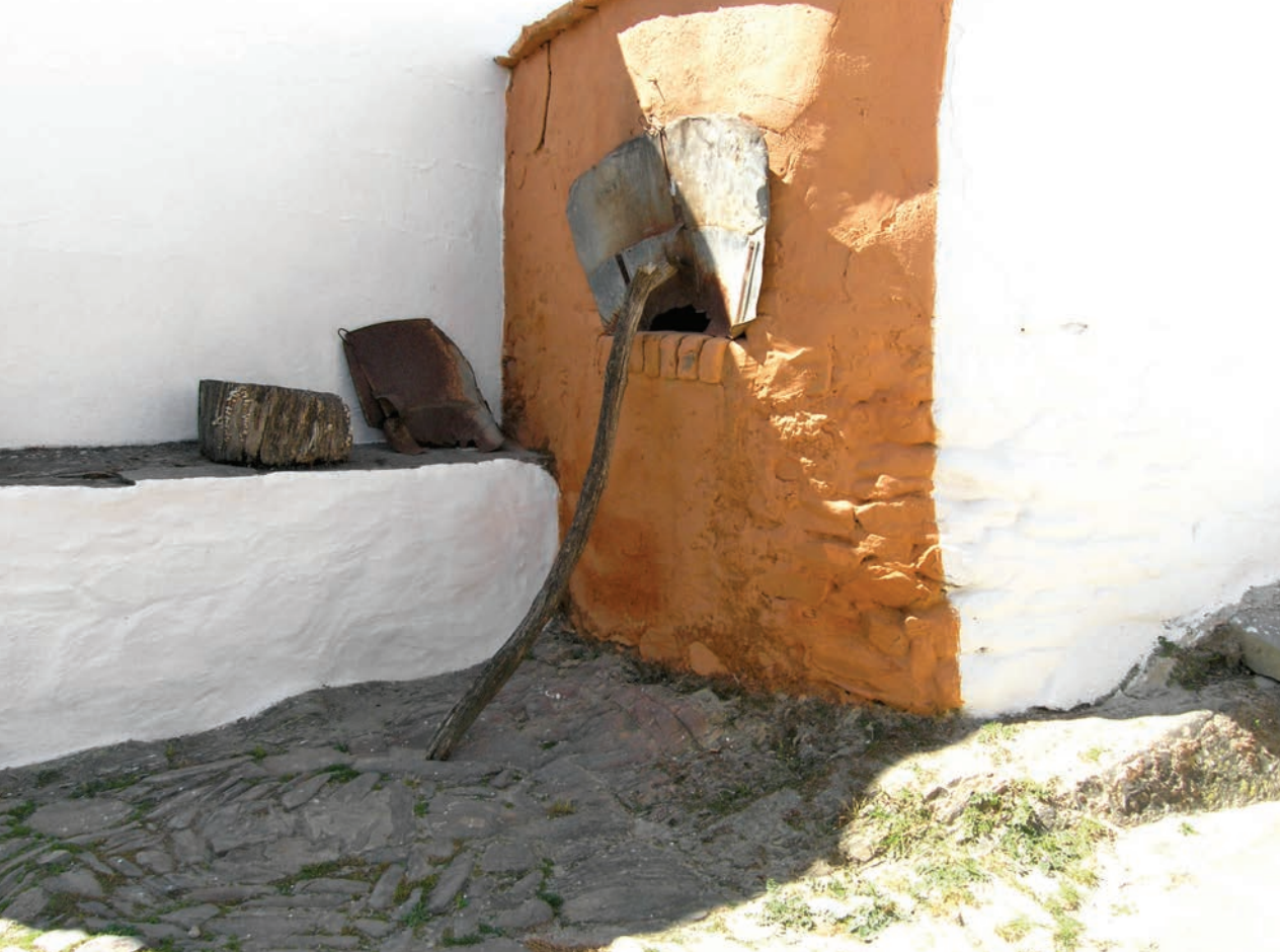
O barro diluído utilizado como alternativa à caiçação. Mestras, Alcoutim.
