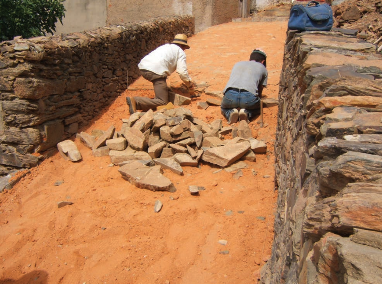
Execução de calçada. Obra de Requalificação da azinhaga de acesso às construções de planta circular (projecto e acompanhamento de obra: GTAA Sotavento). Cachopo, Távira. fotografia GTAA Sotavento
