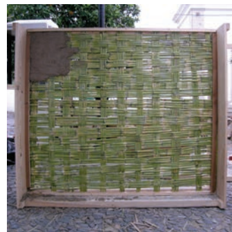
de cima para baixo Pano de chaminé construído em esteira de canas, rebocada apenas pelo exterior. Ribetinha, Tavira; Tabique de canas estruturado por barroteiros verticais de madeira. Ferrarias, Alcoutim; Tabique de canas estruturado por barroteiros e canas, colocados ao alto. Mealha, Tavira; Demonstração da execução de um tabique de entrelaçado de canas, para rebocar. Mértola.
