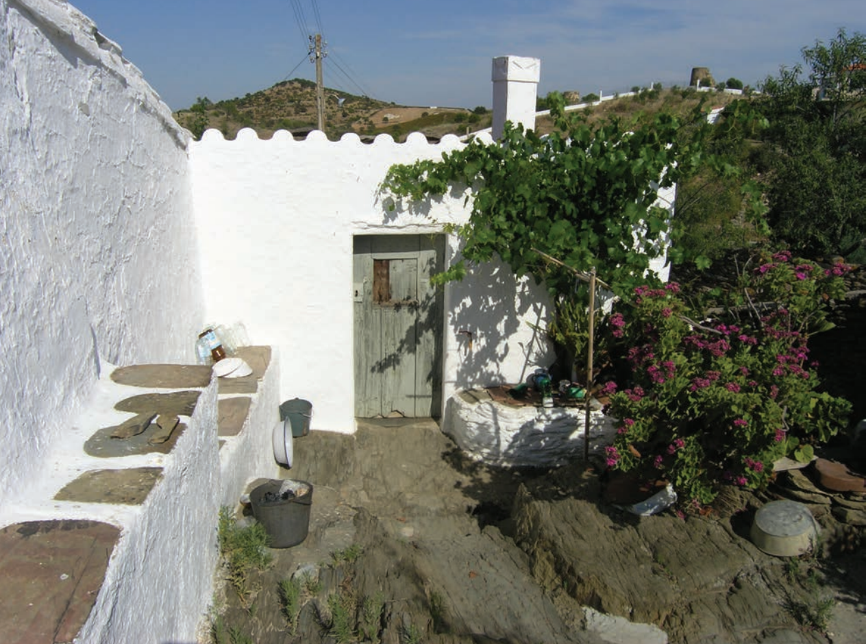
Porta (tipo B) de taipal de madeira, de folha única, com postigo, sem vidro, encerrado por portada interior. Cortes Pereira, Alcoutim.
