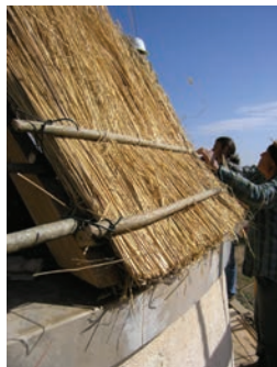
Aspectos da execução de cobertura cónica de palha de centeio. Moinho Branco de Cachopo, Távora.
