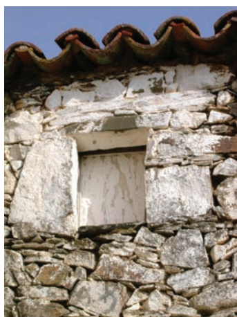
Vão de porta de ramada com ombreiras de pedra, sem golas, e verga constituída por grandes pedras de xisto. Velhas, Alcoutim; Vão de janela de habitação com ombreiras em pedra e verga em arco abalado executado com tijolos de barro cozido. Vaqueiros, Alcoutim; Vão de janela. Fortes, Castro Marim. fotografia GTAA Solavento [1, 3, 4], Miguel Reimão Costa [6]
