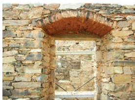
de cima para baixo Aspectos da finalização da execução de um arco em tijolo de barro cozido (antes e depois da desmoldagem). Obra da Casa da Aldeia e Jardim de Cachopo (projecto e acompanhamento de obra: GTAA Sotavento). Cachopo, Tavira fotografia Alexandre Costa
