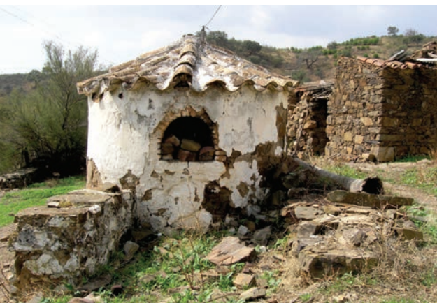
Forno dissociado de planta circular, com poial. Pomar, Vila Real de Santo António.
