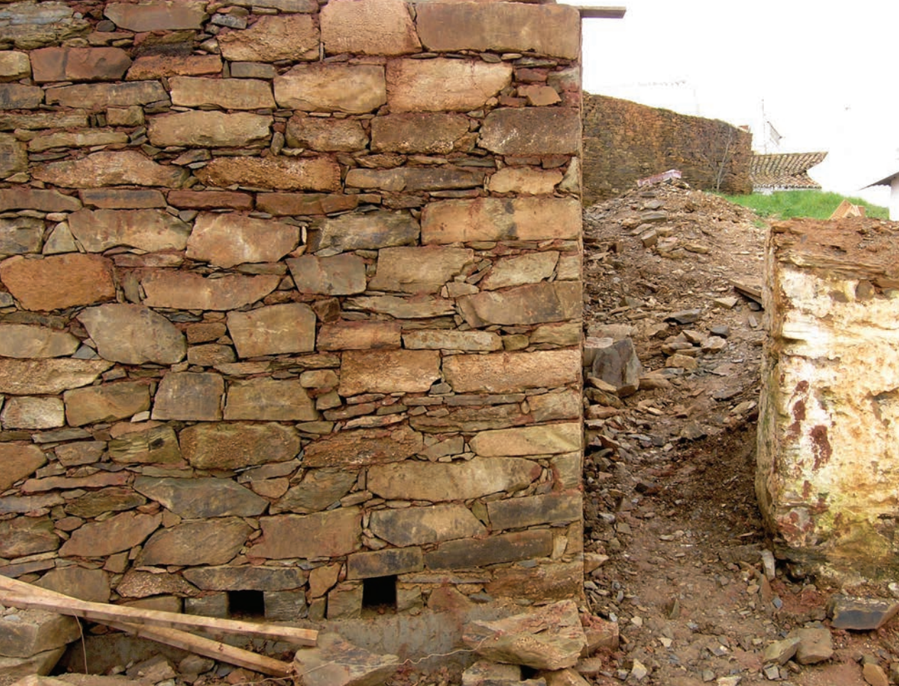
Superfície desempenada e homogénea com as juntas apertadas. Obra da Casa da Aldeia e Jardim de Cachopo (projecto e acompanhamento de obra: GTAA Sotavento). Cachopo, Távira.
