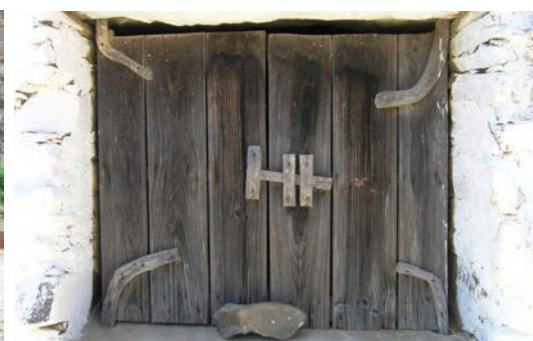
Boqueirão, de duas folhas, de taipal de madeira com gonzos e fechos de madeira. Alcaria Queimada, Alcoutim.
