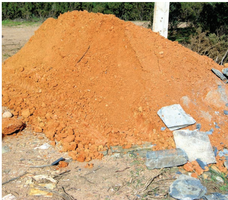
Saibro argiloso para aplicação em calçada. Obra de reconstrução do Moinho Branco (projecto e acompanhamento de obra: GTAA Sotavento). Cachopo, Tavira. fotografia Alexandre Costa
