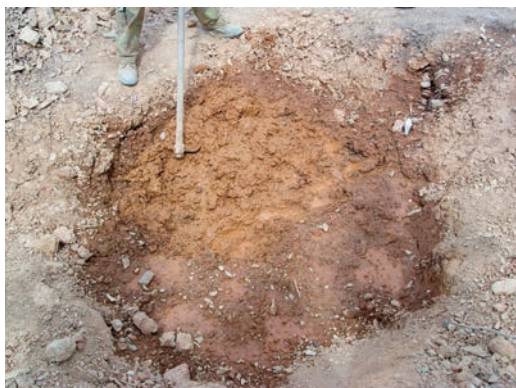
da esquerda para a direita e de cima para baixo Da terra argilosa à mistura com água, até obter a argamassa de barro de assentamento. Obra de Reconstrução do Moinho Branco (projecto e acompanhamento de obra: GTAA Sotavento). Cachopo, Tavira. fotografia Marta Almeida (2, 3, 4)
