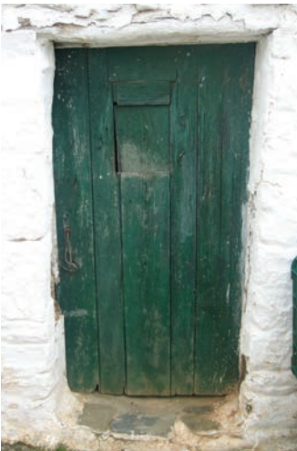
de cima para baixo Porta (tipo A) de taipal de madeira, de duas folhas, uma das quais constituída por duas meias-portas. Martinlongo, Alcoutim; Porta (tipo B) de taipal de madeira, de folha única, com postigo, sem vidro, encerrado por portada interior. Martinlongo, Alcoutim. fotografia Vítor Ribeiro (1, 2)
