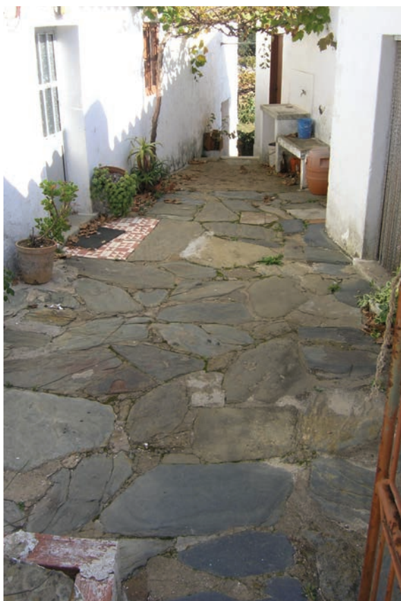
Calçada de lajes de xisto em pátio fronteiro de habitações. Fonte do Corcho, Tavira
