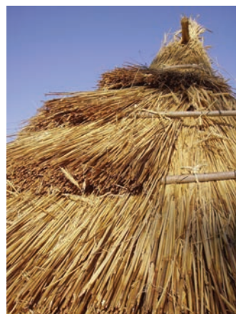
Colocação das fiadas de palha de centeio na execução de cobertura cônica. Oficina “Materiais e técnicas de construção tradicional: conhecer para agir” (organização: GTAA Sotavento, Novembro 2007). Cachopo, Tavira. fotografia Marta Almeida
