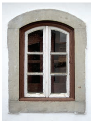
de cima para baixo Janela (tipo C) de duas folhas com postigo protegido por caixilho acoplado envidraçado e portada interior. Cachopo, Tavira. fotografia Vítor Ribeiro; Janela de madeira engradada (tipo D) envidraçada, de duas folhas, com portada interior. Cachopo, Tavira. fotografia Vítor Ribeiro
