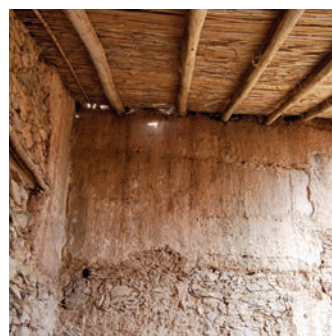
de cima para baixo Edifício construído em taipa nas paredes estruturais, exteriores, e adobe nas paredes divisorias. Alcarías Pedro Guerreiro, Tavira.
