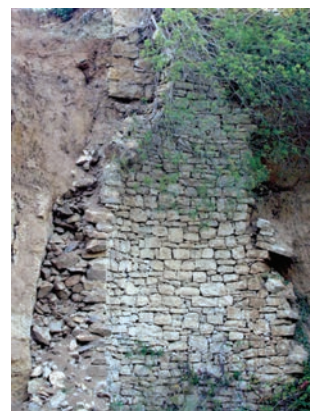
Muro de suporte de poço junto à estrada EN2
