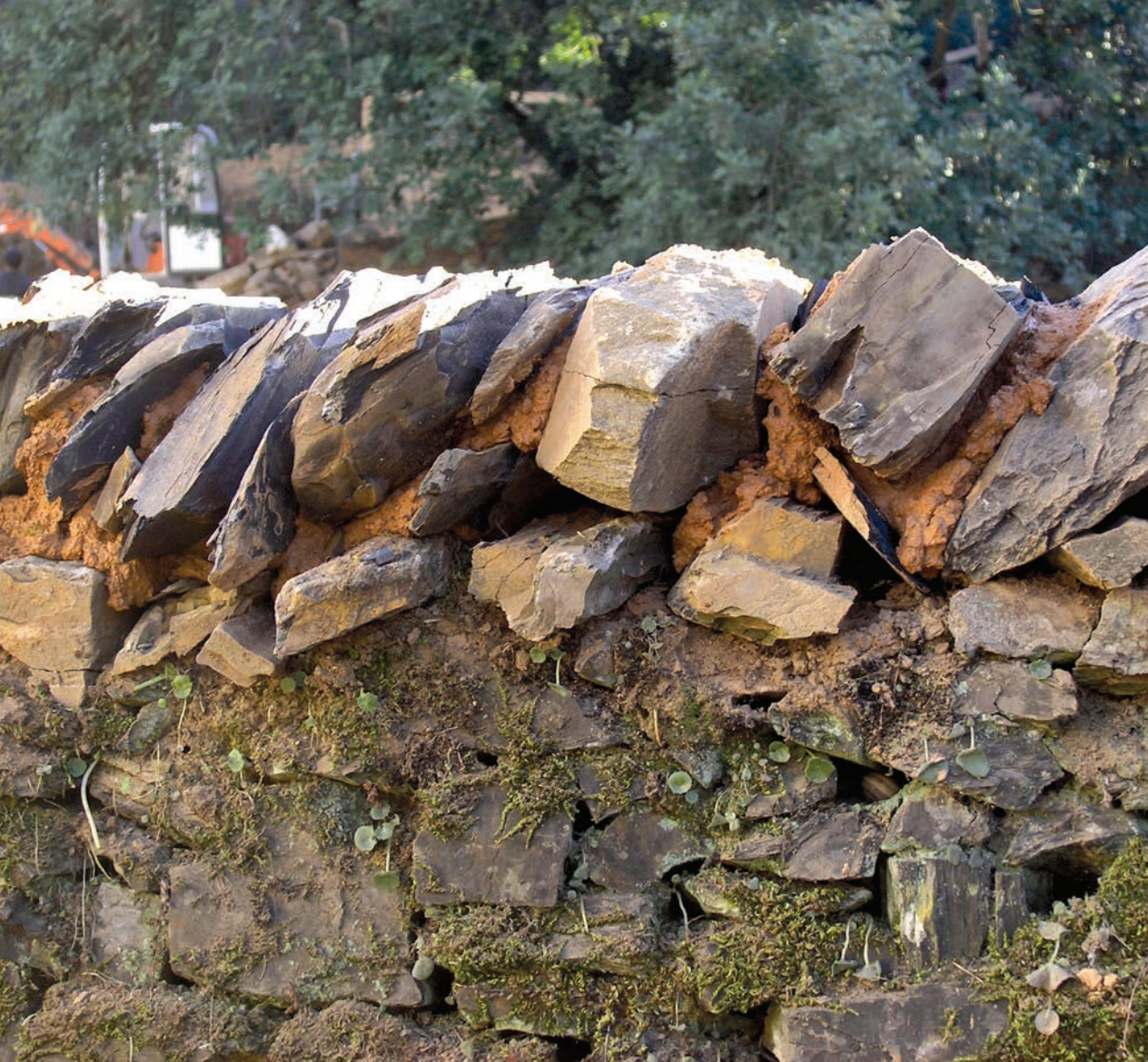
Capeamento, em espigão, de muro de alvenaria de xisto argamassado com barro. Obra de Requalificação da azinhaga de acesso ao poço (projecto e acompanhamento de obra: GTAA Sotavento). Cachopo, Tavira.
