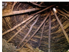
Vista interior de cobertura cônica de palheiro de planta circular, executada com caibros de madeira e varas de esteva. Beliche de Cima, Tavira. fotografia Miguel Reimão Costa
