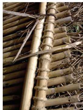
de cima para baixo Assento de cadeira executado com sisal. Mesquita, Alcoutim; Piteira. Pomar, Vila Real de Santo António; Ponto feito com varinha de loendro para fixação dos feixes ao ripado. Mealha, Tavira; Sisal, utilizado na fixação de esteira de canas. Torreão, Alcoutim. fotografia Miguel Reimão Costa (4).
