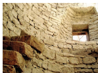
Aspecto da alvenaria após aplicação do salpisco com argamassa de cal hidráulica. Nesta operação, leve-se o cuidado de não tapar demasiado as juntas entre pedras, para que a alvenaria pudesse respirar convenientemente. Obra de Reconstrução do Moinho Branco (projecto e acompanhamento de obra: GTAA Sotavento). Cachopo, Távira. fotografia Alexandre Costa
