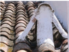
em baixo Chaminé de fogo livre. Vale da Rosa, Alcoutim. fotografia Miguel Reimão Costa; Chaminé de fogo livre. Pessegueiro, Alcoutim.
