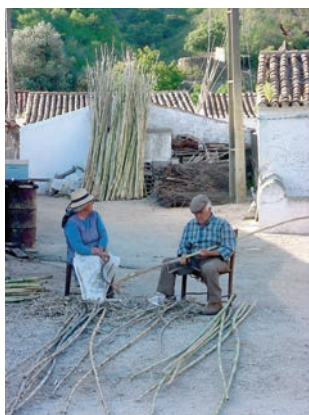
Preparação e limpeza das canas, para utilização na construção. Beliche de Cima, Tavira. fotografia GTAA Sotavento
