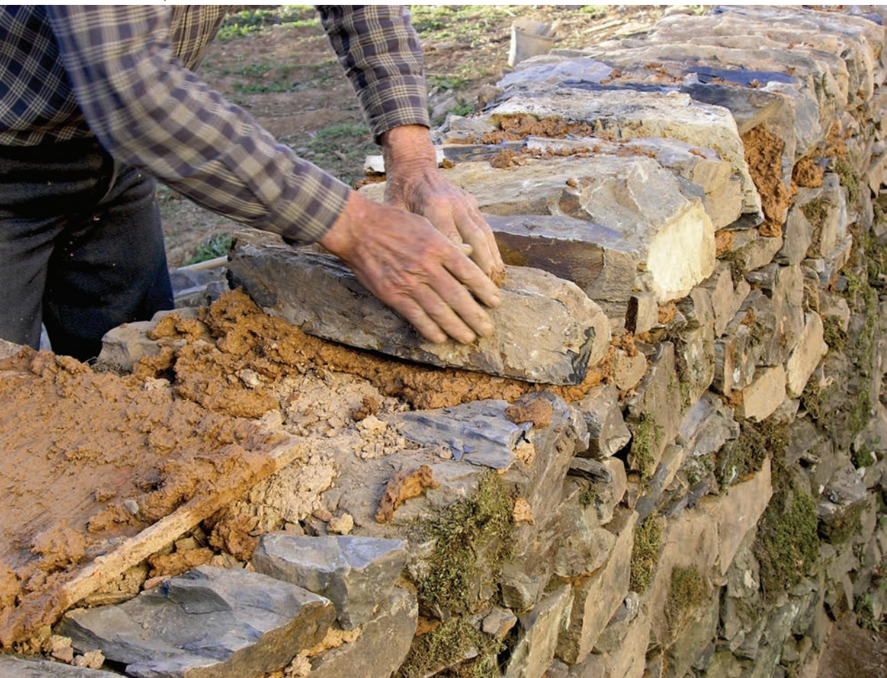
Argamassa de barro usada no assentamento de alvenaria de xisto. Obra de Requalificação do acesso ao poço (projecto e acompanhamento de obra: GTAA Sotavento). Cachopo, Tavira.
