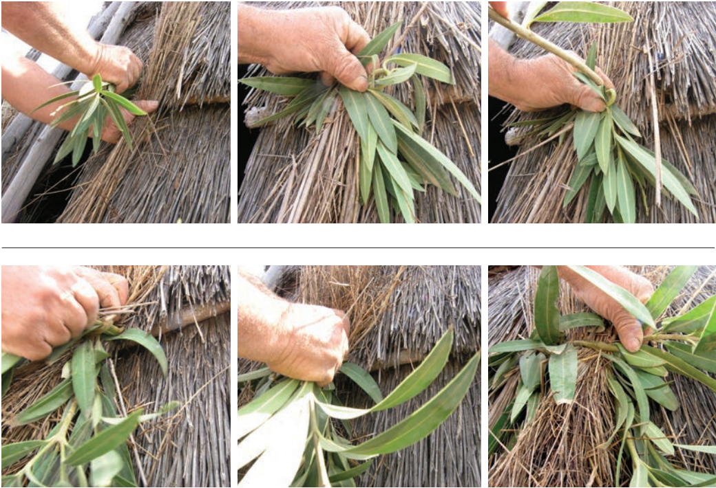
da esquerda para a direita e de cima para baixo Demonstração da execução do ponto com varinha de loendro. Mealha, Tavira
