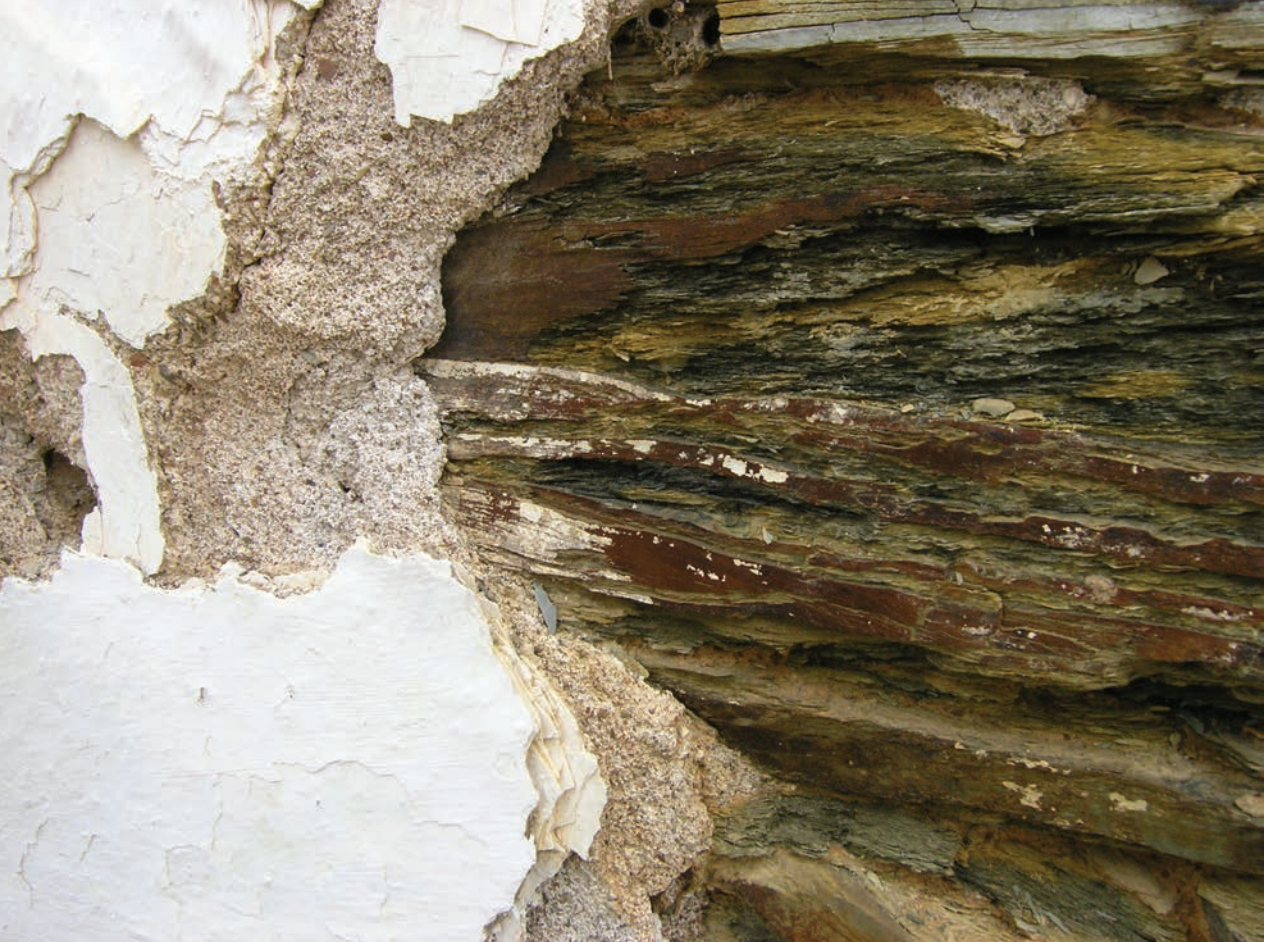
Argamassa de revestimento de cal aérea e caiação. Cachopo, Tavira
