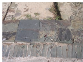
de cima para baixo Pedras de formação não lamelar, popularmente chamadas de pedra parda , com resistência e dureza mais apropriadas para aplicação em calçadas. Mealha, Távira.
