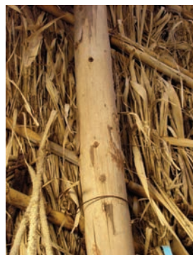
de cima para baixo Pormenor da fixação das canas e do revestimento à estrutura da cabana. Torneiro, Alcoutim.
