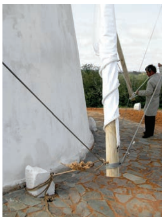
Colocação das velas. Moinho Branco de Cachopo, Tavira. fotografia GTAA Sotavento
