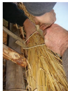
da esquerda para a direita e de cima para baixo Oficina “Materiais e técnicas de construção tradicional: conhecer para agir” (organização: GTAA Sotavento, Novembro 2007). Cachopo, Tavira. Exercício de amarração no sistema de ripagem dupla.
