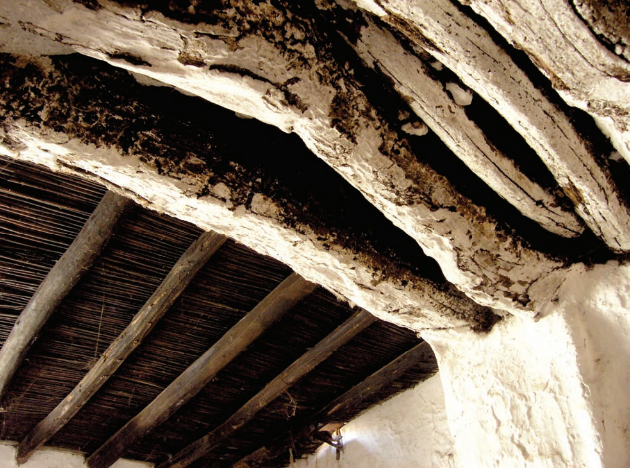
Verga de vão de porta constituída por conjunto de caibros de madeira (em primeiro plano) e cobertura constituída por caibros de madeira e forro de canas. Ribeirinha, Tavira.
