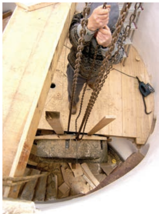
Colocação da mó. Moinho Branco de Cachopo, Tavira.
