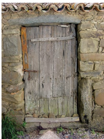
Vão de porta de ramada com ombreiras de pedra, sem golas, e verga constituída por grandes pedras de xisto. Velhas, Alcoutim; Vão de janela de habitação com ombreiras em pedra e verga em arco abalado executado com tijolos de barro cozido. Vaqueiros, Alcoutim; Vão de janela. Fortes, Castro Marim. fotografia GTAA Solavento [1, 3, 4], Miguel Reimão Costa [6]
