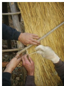
da esquerda para a direita e de cima para baixo Oficina “Materiais e técnicas de construção tradicional: conhecer para agir” (organização: GTAA Sotavento, Novembro 2007). Cachopo, Tavira. Exercício de amarração no sistema de ripagem dupla.
