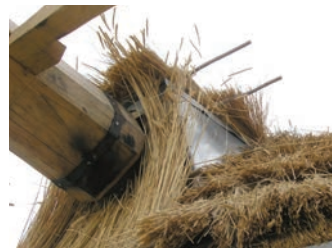
Aspectos da execução de cobertura cónica de palha de centeio. Moinho Branco de Cachopo, Távora.
