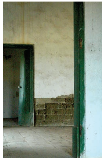
de cima para baixo Parede divisória interior em alvenaria de adobes. São Martinho, Alcoutim; Parede divisória interior em alvenaria de adobes. Alcarías Pedro Guerreiro, Tavira.
