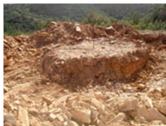
Escavação, até à rocha, para assentamento das alvenarias de um moinho de vento. Obra de Reconstrução do Moinho Branco (projecto e acompanhamento de obra: GTAA Sotavento). Cachopo, Tavira. fotografia Sílvia Bento
