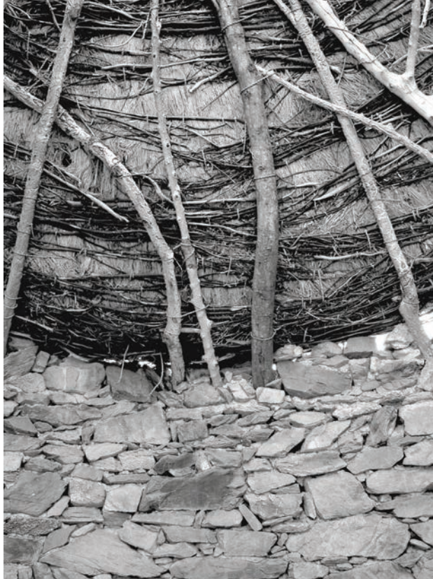
Vista interior de cobertura cônica de palheiro de planta circular, executada com caibros de madeira e varas de esteva. Malthadinha, Tavira. fotografia Helder Oliveira
