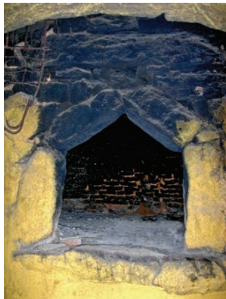
de cima para baixo Boqueirão com ombreiras de pedra, sem golas, verga constituída por paus de azinho e peitoril em lajetas de pedra. Madeiras, Alcoutim.
