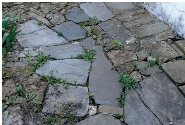
da esquerda para a direita e de cima para baixo Platibanda. Catraia, Tavira; Chaminé de grelha. Catraia, Tavira; Forno de pão associado a casa do fogo. Estevais, Tavira; Pavimento em lajes de xisto. Fonte do Corcho, Tavira.
