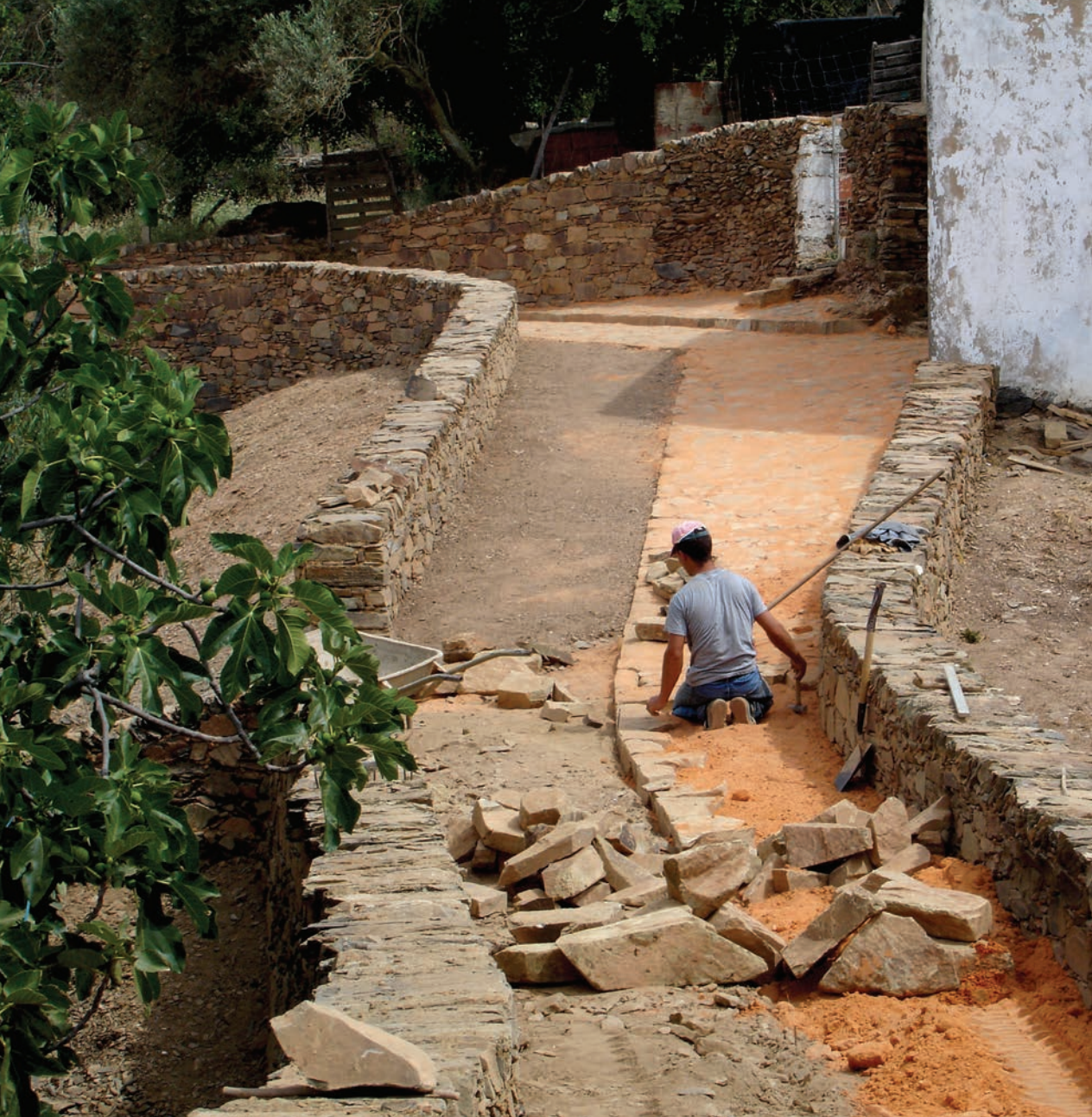
Saibro argiloso aplicado na execução de calçadas. Obra de Requalificação da azinhaga de acesso às construções de planta circular (projecto e acompanhamento de obra: GTAA Sotavento). Cachopo, Távira. fotografia Sílvia Bento
