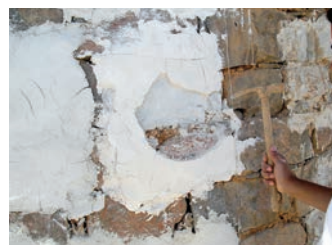
de cima para baixo Vários testes, nomeadamente de fissuração e aderência ao suporte, realizados a argamassas de reboco. Obra de Reconstrução do Moinho Branco (projecto e acompanhamento de obra: GTAA Sotavento). Cachopo, Távira. fotografia Alexandre Costa
