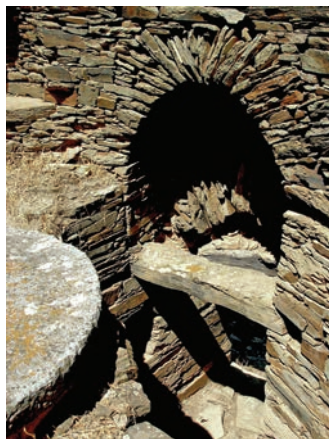
Vão de porta de moinho de vento com verga constituída por elementos horizontais e dois arcos de distribuição de cargas. Catraia, Tavira. fotografia Alexandre Costa
