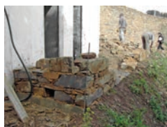
Arranque de uma alvenaria de xisto, com o auxílio de estacas e fios de marcação para um correcto alinhamento. Obra de Requalificação do acesso ao poço (projecto e acompanhamento de obra: GTAA Sotavento). Cachopo, Tavira. fotografia Alexandre Costa
