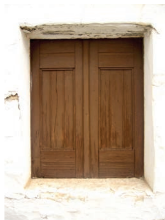
de cima para baixo Janela (tipo A) de taipal de madeira, de duas folhas. Cachopo, Tavira. fotografia Vítor Ribeiro; Janela (tipo B) de duas folhas com postigo, sem vidro, encerrado por portada interior. Martimlongo, Alcoutim. fotografia Vítor Ribeiro
