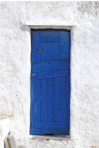
em baixo, da esquerda para a direita Porta (tipo B) de taipal de madeira, de folha única, com postigo, sem vidro, encerrado por portada interior. Alcarías Pedro Guerreiro, Tavira; Porta (tipo C) de taipal de madeira, de folha única, com postigo envidraçado, com portada interior. Serro da Vinha de Baixo, Alcoutim; Porta (tipo B) de taipal de madeira, de folha única, com postigo, sem vidro, encerrado por portada interior. Alcarías Pedro Guerreiro, Tavira.
