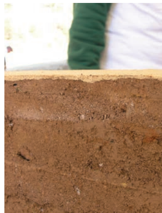
em baixo Muro de taipa construído no âmbito da Oficina "Materiais e Técnicas de Construção Tradicional: conhecer para agir" (organização: GTAA Sotavento, Novembro 2007). Cachopo, Tavira.
