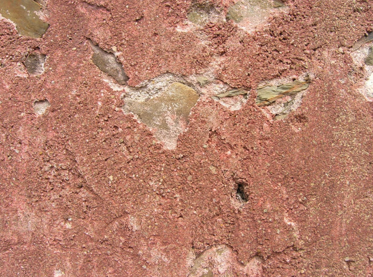
Barramento. Silgado, Alcoutim.
