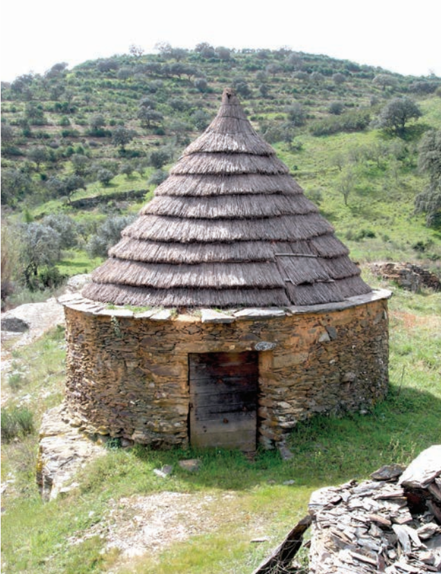
Palheiro de planta circular com cobertura revestida por fiadas de molhos de palha de centeio. Mealha, Tavira.
