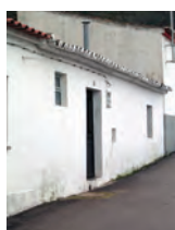
19 edifício de volumetria integrada no conjunto.
