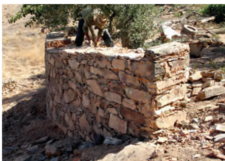
figura 364 Muro de suporte de alvenaria seca de xisto em execução no acesso às construções circulares Sílvia Bento
