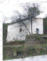
24 edifício com interesse e valor de conjunto.
