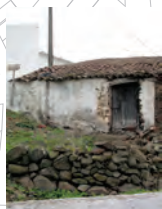
41c edifício com valor de conjunto, em ruína.
