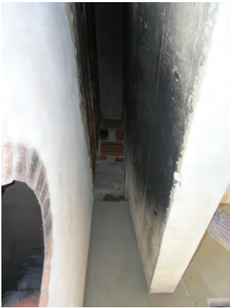
figura 311 Vista exterior da chaminé do forno de pão f S M
