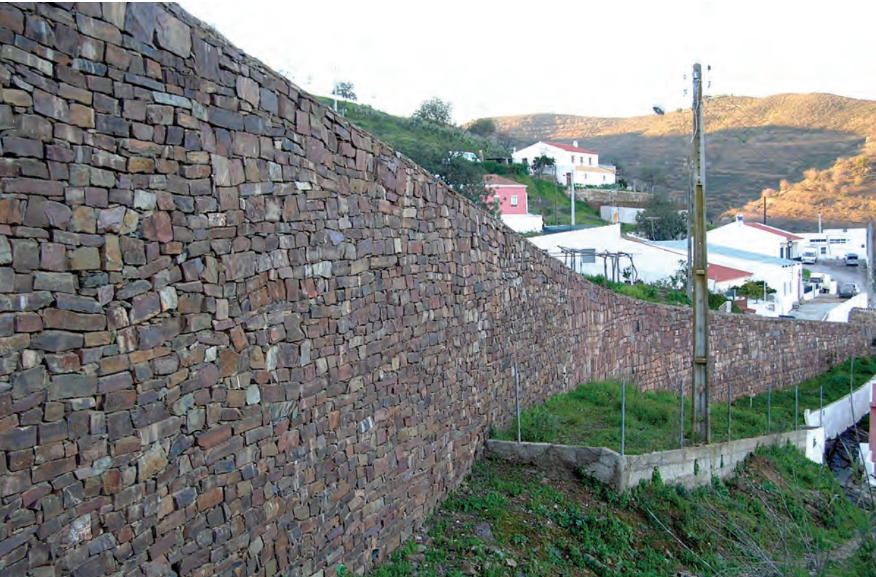
figura 161 Alvenaria de xisto, vista geral do muro de suporte FSM
