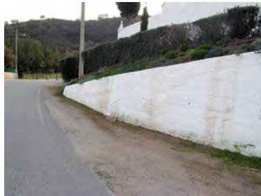
figura 109 Acesso ponte, muro de suporte fGTAA
