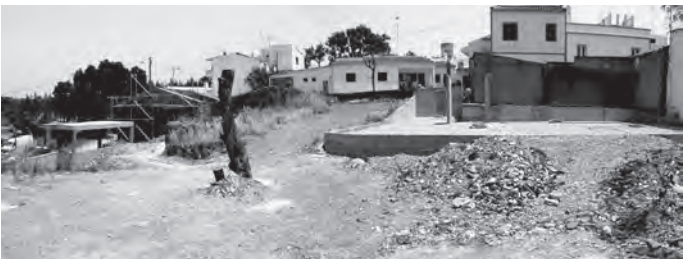
figuras 285 e 286 Vista geral da área de intervenção em fase obra fGTA e fSM
