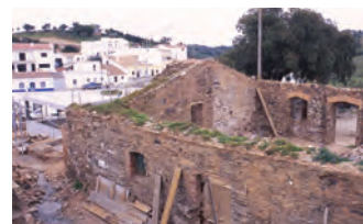
figura 289 Edifício A em fase de obra f A J
