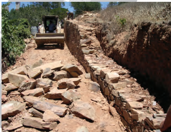
figura 358 Muro de suporte de alvenaria seca de xisto em execução f GTAA
