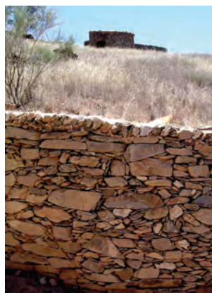
figura 362 Muro de suporte de alvenaria seca de xisto reconstruído, no troço sul/poente do percurso, com construções circulares em fundo fGTAA
