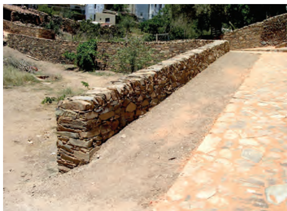
figura 361 Calçada e muro de xisto reconstruído no troço norte do percurso fGTAA
