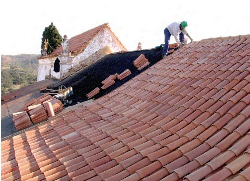
figura 261 Revestimento da cobertura com telha de canudo Miguel Reimão Costa
