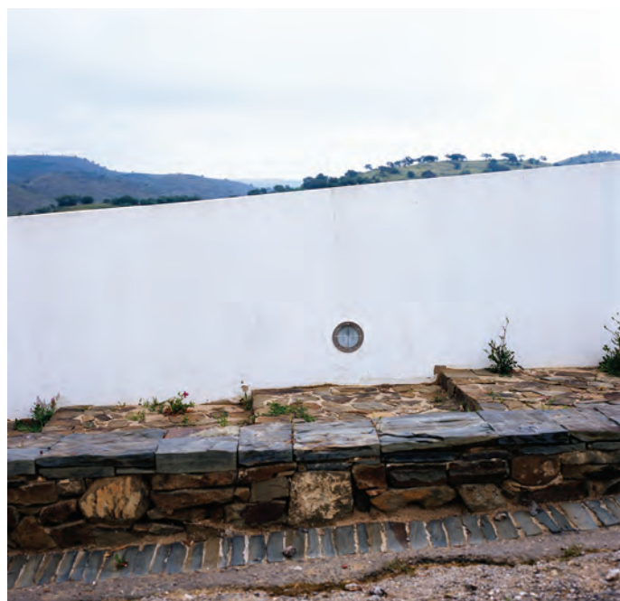
figura 167 Pormenor de caleira, murete, degraus e iluminação embutida fAJ
