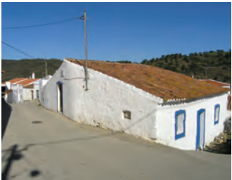
figura 388 Vista do Largo 25 de Abril f S M
