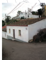
20 edifício de volumetria integrada no conjunto.
