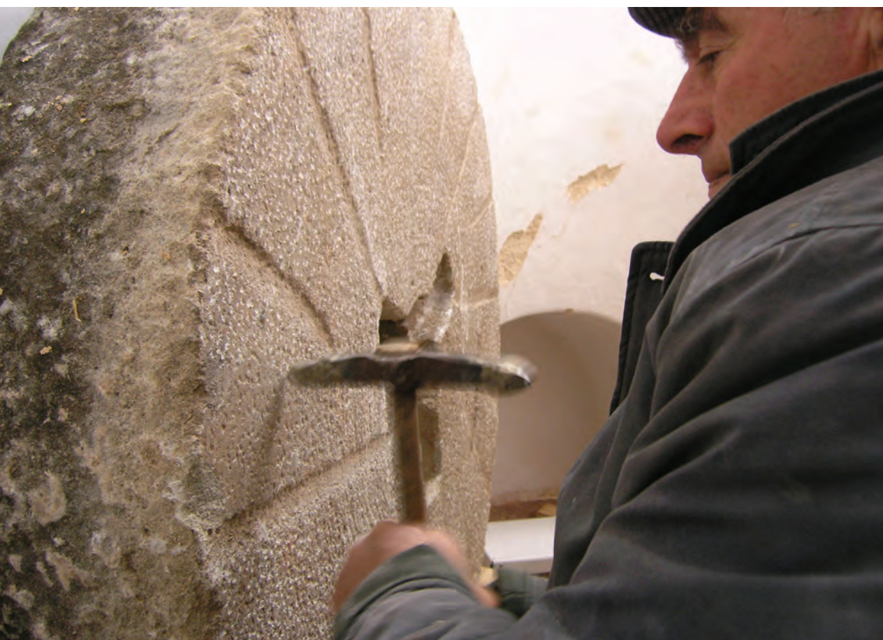
figura 8 Cachopo, Reconstrução do Moinho Branco: picagem da mó f S M
