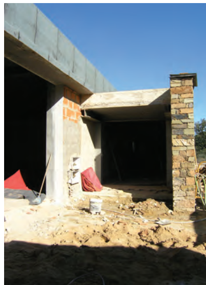
figura 315 Entrada da sala de arrumos a.05 f S M
