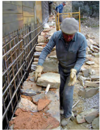
figura 342 Construção do muro de suporte misto de alvenaria de xisto e betão armado Alexandre Miguel Costa
