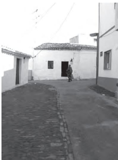
figura 51 (dir.) Calçada de xisto com guia de drenagem dupla de xisto a cutelo ao eixo da via
