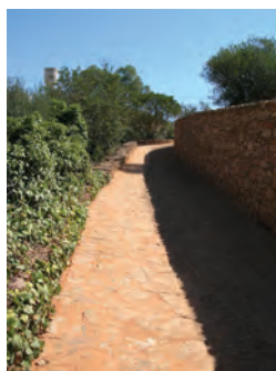
figura 359 Calçada e muro de xisto reconstruído no troço sul/ poente do percurso f GTAA
