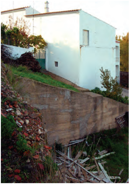
figura 107 Escada de acesso à Rua de S. Luís fGTAA
