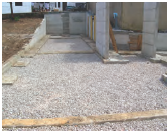
figuras 293 Edifício D em fase de obra f G T A A
