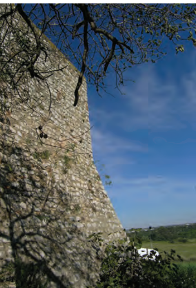
figura 14, 15, 16 Fortaleza, Cisterna, Arruamento a Norte f S M
