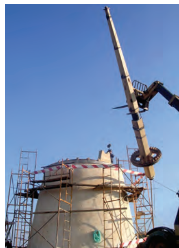
figura 231 Colocação do mastro f G T A A
