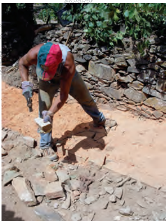
figura 357 Calçada de xisto em execução f GTAA
