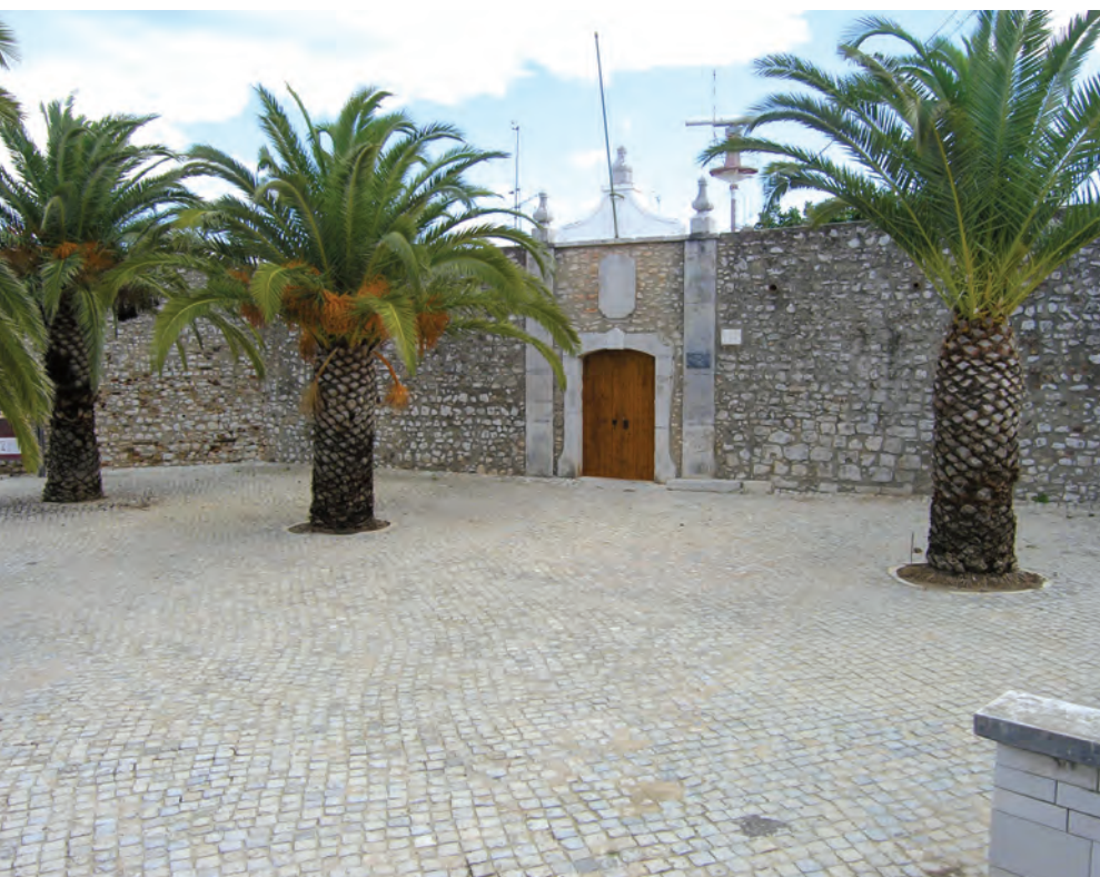
figura 19 Espaço fronteiro à entrada da Fortaleza f S M
