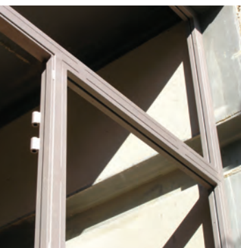
figura 316 Caixilharias metálicas com acabamento em esmalte forja f S M
