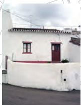
37b edifício com interesse e valor de conjunto.
