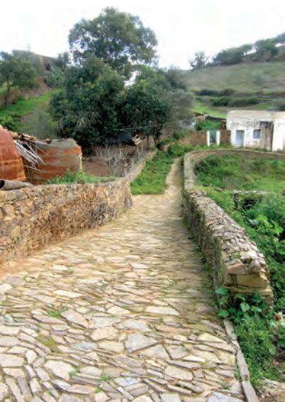
figura 353 (à esq.) Calçada e muros de xisto reconstruídos no troço norte do percurso f s M
