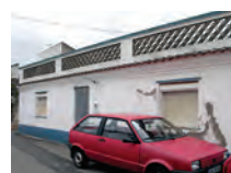
59 edifício de volumetria integrada no conjunto.
