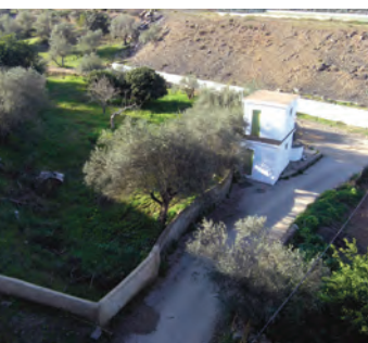
figura 370 Área A, casa do poço f S M
