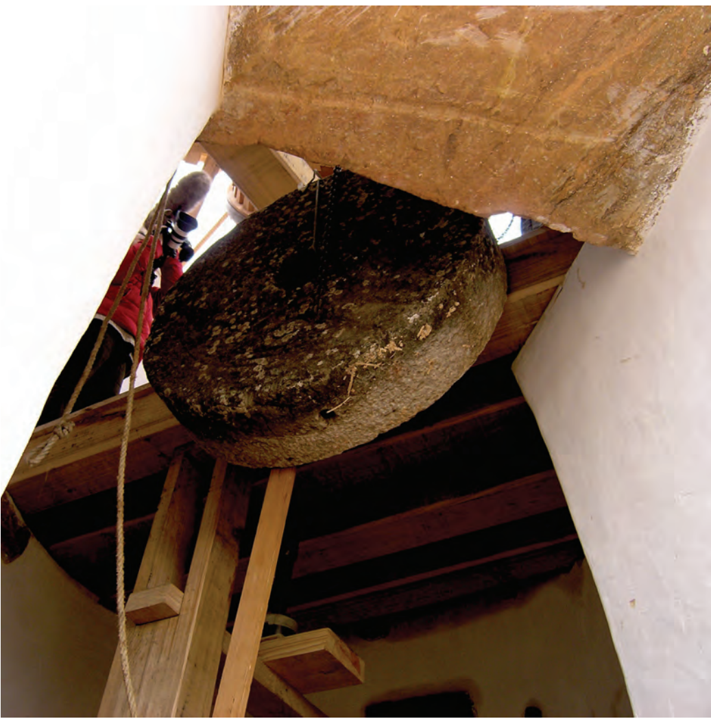
figura 211 Aspecto da mó a ser içada f S M
