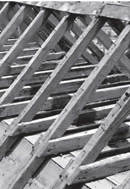
figura 260 Pormenor da estrutura da cobertura antes da intervenção Miguel Reimão Costa
