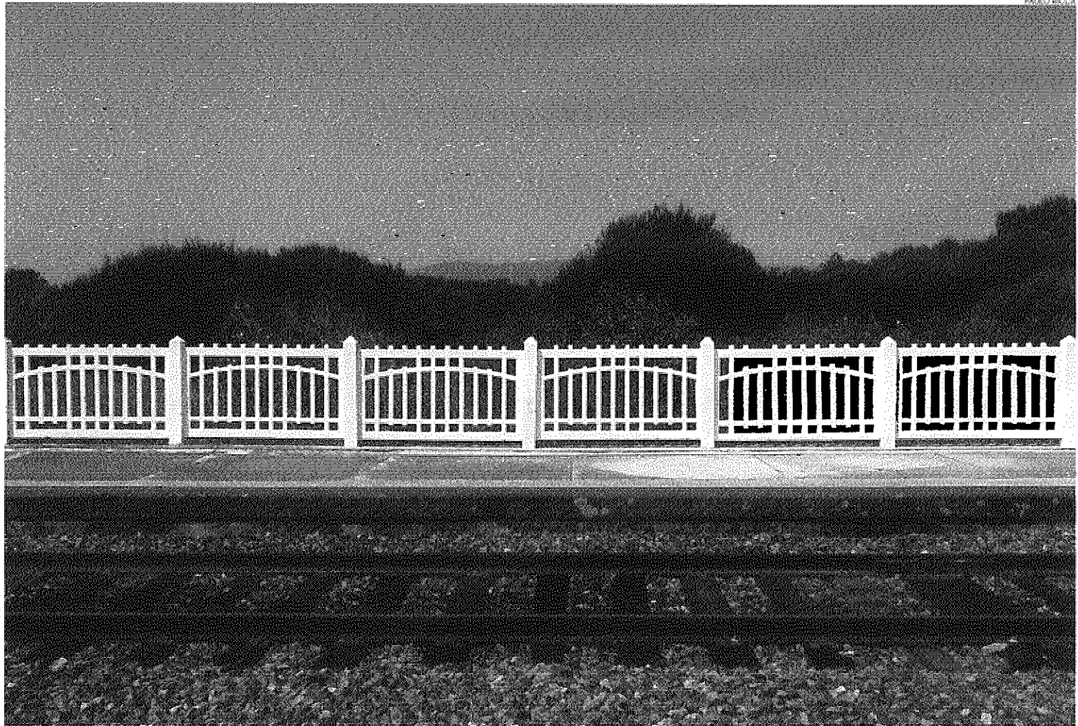
A Linha do Algarve mede 141 quilómetros, dos quais apenas o troço central de 40 quilómetros (Faro-Tunes) está electrificado
